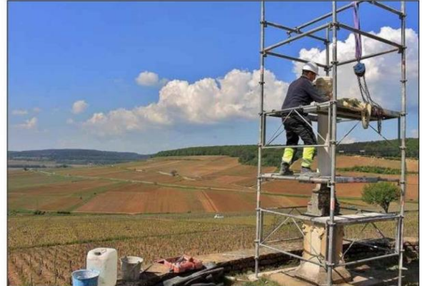
Deux employés de l'entreprise de maçonnerie Guy Bernard étaient déjà en action le mardi matin du 3 mai, pour installer deux des trois morceaux de la croix, l'un taillé pour l'occasion, l'autre nettoyé et rénové. Photo LBP/M. D.
